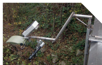
TBR solaire associé à un radar CRUZOE
