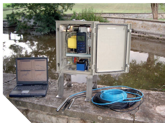
Installation d'un MAC dans un coffret
