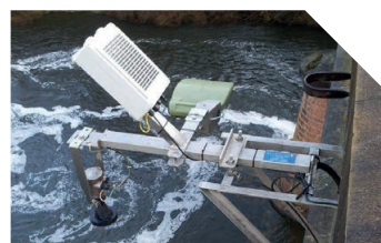
TBR solaire à la Roche-la-Molière
