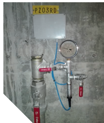
Installation d'un capteur TPC
