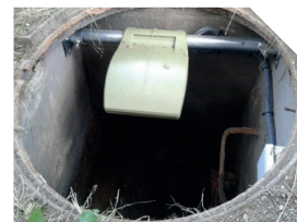
Mesure dans un puits
